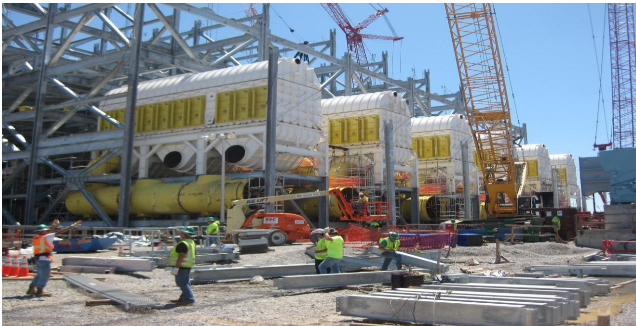
Рис. 3. Монтаж сушилок кипящего слоя HDC 9250 на тепловой электростанции IGCC (США, штат Миссисипи)
